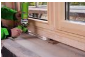
Ablakcsatlakozó fuga kitöltése FM230-al.
