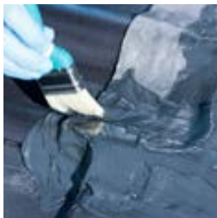
2. Roztretie štetcom. Je možné aplikovať aj viac vrstiev.
