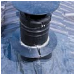
4. Membrána vytvára funkčný a pritom čistý elastický detail
