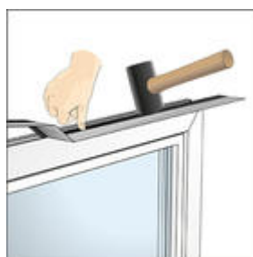
Afb. 3: Het geschikte profiel met rubberhamer aanbrengen.
