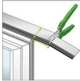
Bild 15: Folie im Eckbereich mit einem Breitenüberstand abschneiden
