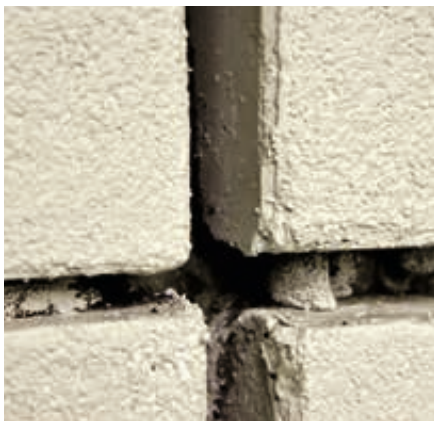
Mangelhafte Abdichtung des traditionellen Plattenbaus stellt Planer vor große Herausforderungen
