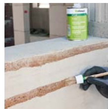
4. Príprava muriva a penetrácie.
