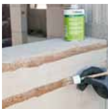
4. Příprava zdiva a penetrace.
