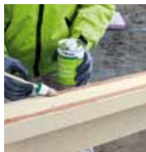
3. Příprava lepených ploch podkladním nátěrem nátěrem illbruck AT140.
