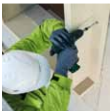
7. Zajištění absolutního přitlaku profilů ke zdivu pomocí pojistných šroubů.
