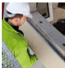
6. Instalace L profilu PR010 na zdivo.
