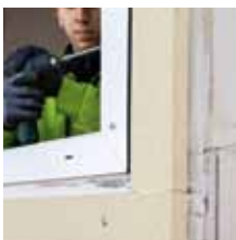
8. Upevnění okenního rámu pomocí okenních šroubů. Utěsnění připojovací spáry komprimační páskou TP654 illmod Trio 1050.
