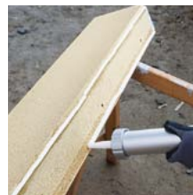
5. Aplikace lepidla SP340 na rám ve dvou housenkách.
