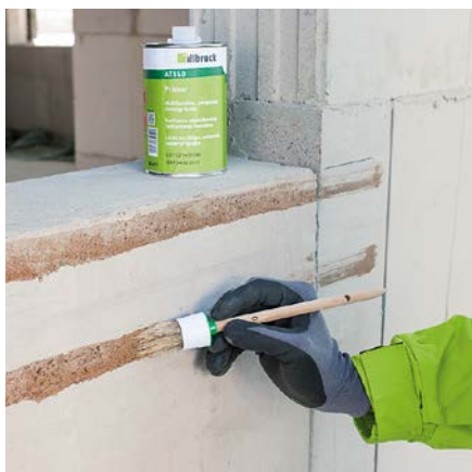
Abb. 4: Reinigen Sie auch das Mauerwerk entsprechend und primern Sie es.
