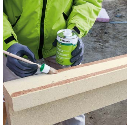
Abb. 3: Reinigen Sie alle Klebeflächen und behandeln Sie diese mit illbruck AT140 Primer vor.
