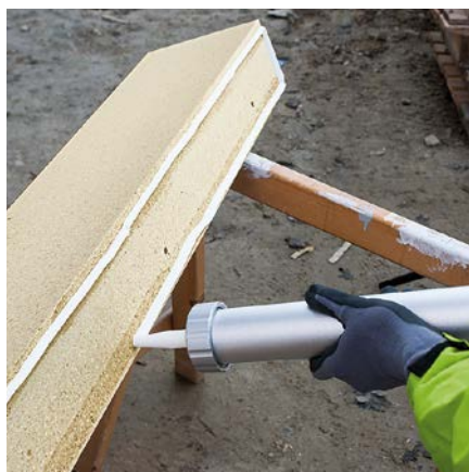
Abb. 5: Tragen Sie den SP340 Soforthaft-Kleber in zwei Strängen auf die Zargen auf.
