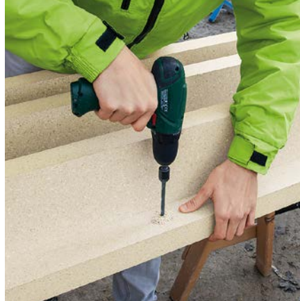
Abb. 2: Bohren Sie die Löcher für die Sicherungsschrauben vor.
