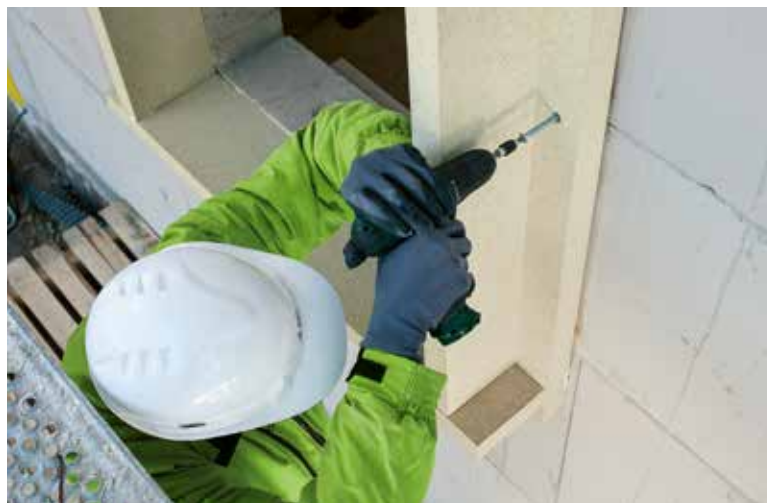
Zabezpečenie absolútneho prítaku profilov na murivo poistnými skrutkami
