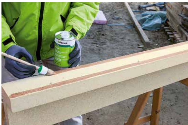
Príprava nosných materiálov podkladovým náterom
