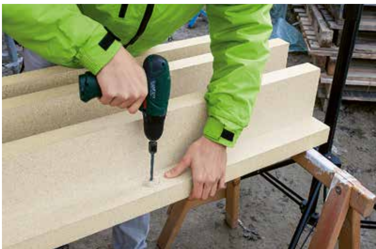
Predvrtávanie otvorov na zabezpečovacie skrutky
