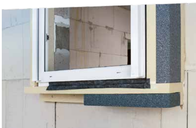
Aplikácia hydroizolačnej fólie proti tlakovej vode a izolačných klinov
