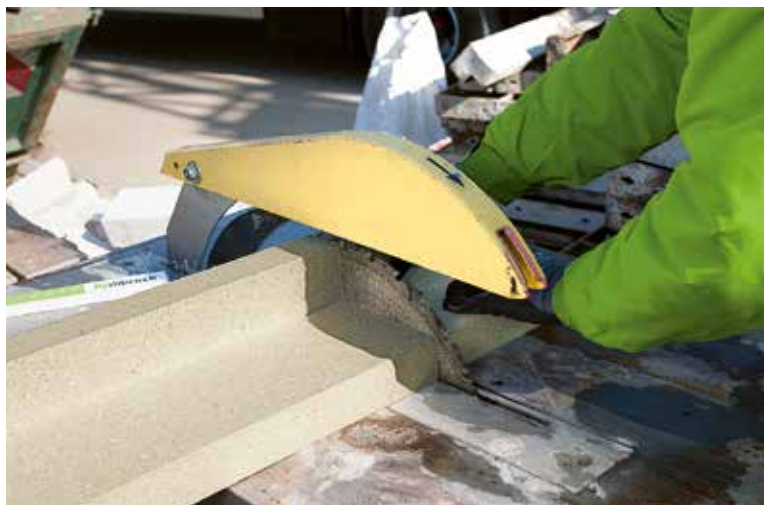
Príprava rámu (úprava na potrebnú dĺžku)
