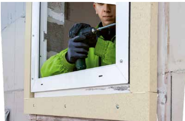
Upevnenie okenného rámu pomocou okenných skrutiek. Utesnenie pripájajúcej škáry komprimačnou páskou
