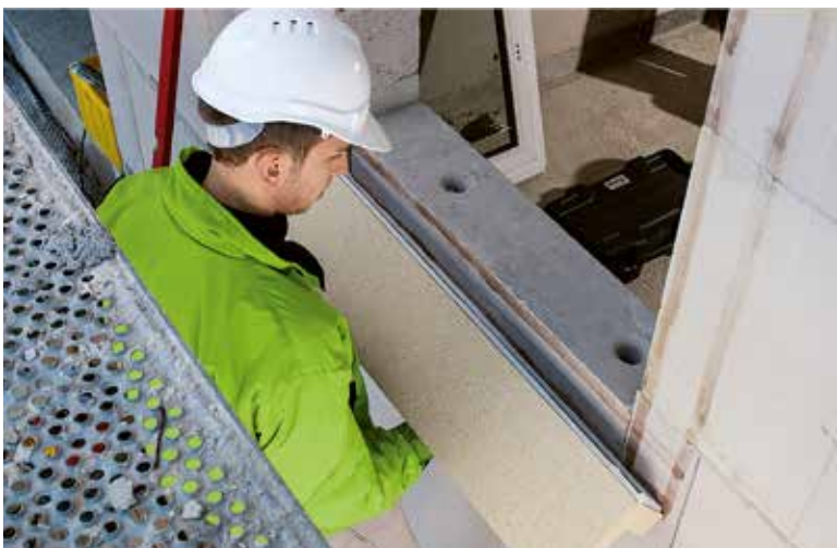
Inštalácia nosných profilov
