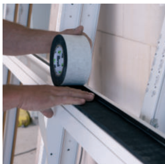
Aplikácia TP652 na rám okna. Jednoduché, rýchlo a čisto.
