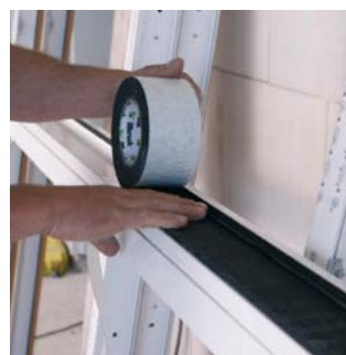
Aplikace TP652 na rám okna. Jednoduše, rychle a čistě.
