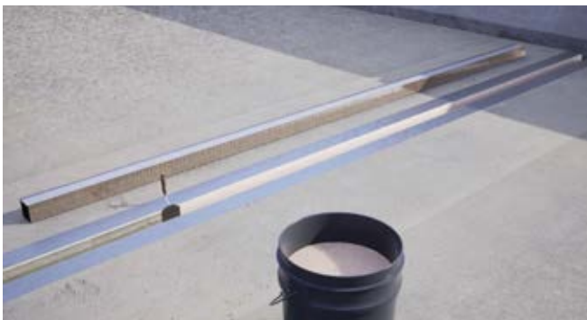
Aplicar la mezcla epoxi en ambos lados de la junta.
