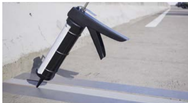
Sellar todas las juntas, incluyendo las que conectan los perfiles, con el sellador FA880 de illbruck.
