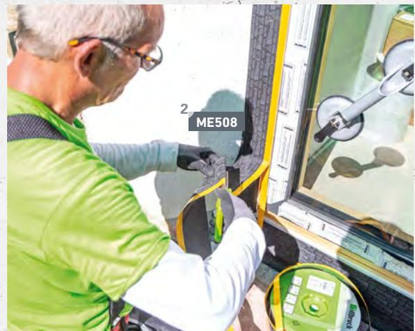
ME501 TwinAktiv (Anschlussflansch) durchgängig bis Fußpunkt montieren und vollflächig am Mauerwerk verkleben.
