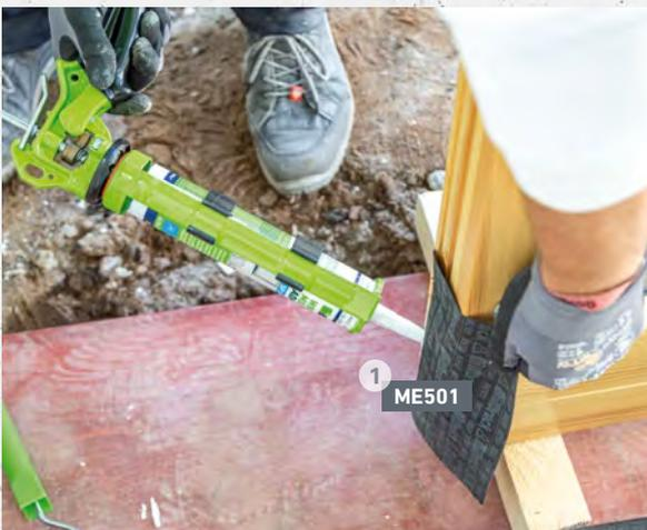
ME501 TwinAktiv (Anschlussflansch) zusätzlich mit SP351 Fenstermontage-Kleber verkleben.
