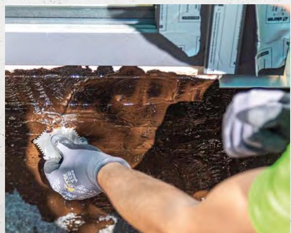
Schichtdickenkontrollen der aufgetragenen Schichten durchführen.
