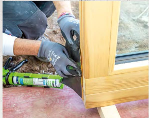
ME501 TwinAktiv (Anschlussflansch) seitlich am Blendrahmen mittels Selbstklebung befestigen.
