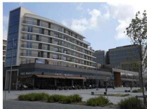
Le Bâtiment F2 est quant à lui un immeuble de bureaux avec ITE (Isolation Thermique par l'Extérieur) et des murs-rideaux avec pré-cadres aluminium, sur lesquels il faut assurer de bonnes performances d'étanchéité à l'air et d'acoustique. La solution retenue ici est la pose en applique extérieure avec TP651 illmodTrio PA.
