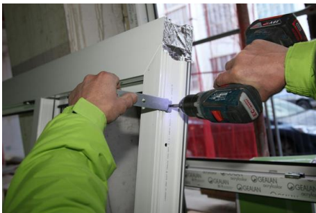
Bild 1: Verschraubung am Fenster
