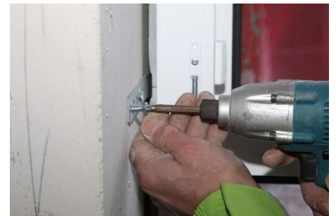
Bild 3: Befestigung am Mauerwerk
