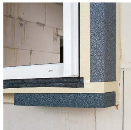
Abb. 9: Verkleben Sie unter der Aussenfensterbank eine ME503 TwinAktiv VZ Folie gegen drückendes Wasser. Bei Bedarf können die Zargen mit dem passenden PR008 Dämmkeil ergänzt werden.
