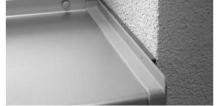
Zwischen Endprofil und Laibung ist eine ausreichend breite Fuge anzuordnen und diese mit einem vorkomprimierten Fugendichtungsband (BG1) abzudichten.
