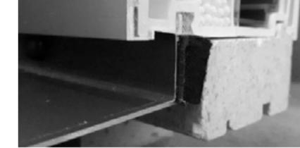
Fensterbänke sind am Fensterbankanschlussprofil des Fensters zu befestigen und mittels einem vorkomprimierten Fugendichtungsband oder geeignetem Dichtprofil abzudichten. (In der Mindestbreite des Anschraubstegs bzw. der Materialstärke bei Steinfensterbänken)
