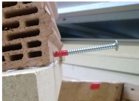
Hochlochziegel, MW-Abstand ca. 10 mm
