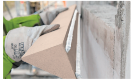
Rys.3 Ustawić i przytwierdzić do muru dolny profil ramy instalacyjnej
