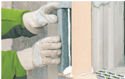
Rys.5 Przykleić klin izolacyjny PR008. Zamontować okno z pomocą taśmy rozprężnej TP652
