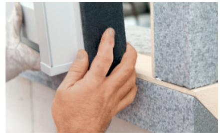
Rys.6 Przygotowana rama pod montaż okna składająca się z profilu instalacyjnego PR007 oraz klinu izolacyjnego PR008
