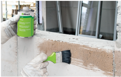
Rys.1 Uciąć profile ramy instalacyjnej na odpowiedni wymiar. Wyczyścić powierzchnie klejenia i zagruntować za pomocą środka AT140
